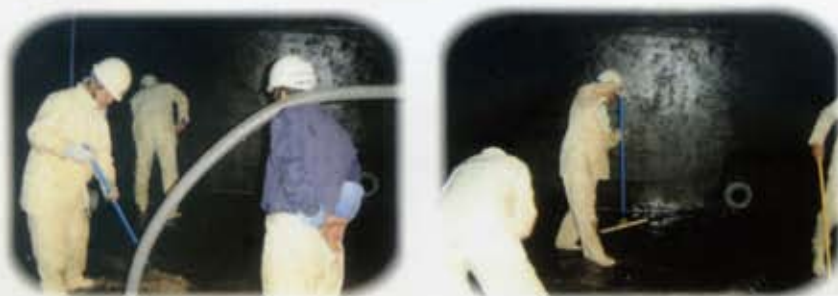
タンク内清掃の様子
